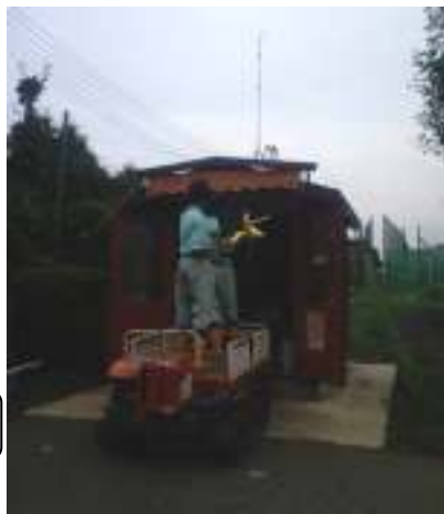
風力発電機設置中
