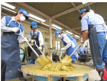
コンクリート手練り
